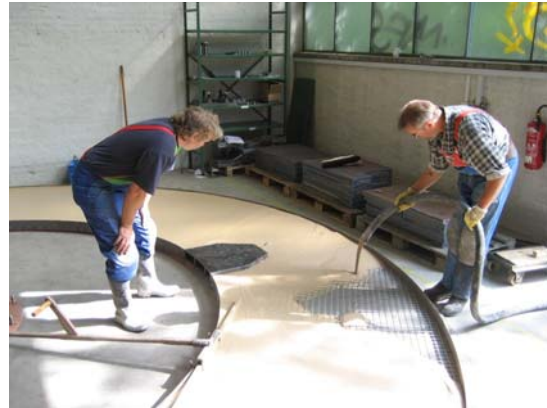
Bild 8.9: Verguss des Bodenbelags in die Metallwanne
