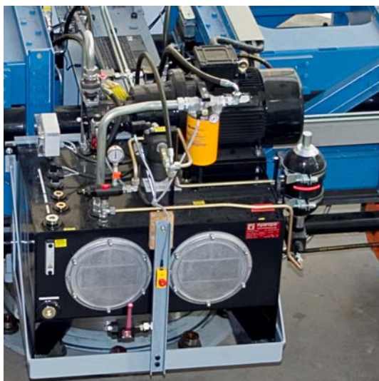
Bild 8.18: Am zentralen Lagerbock befestigtes Hydraulikaggregat
