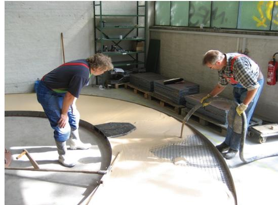
**Bild 8.9:** Verguss des Bodenbelags in die Metallwanne
